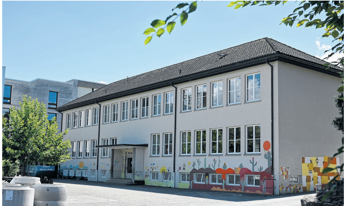
Nun gilt es ernst in Altendorf: Ab Montag werden das sogenannte 40er-Schulhaus sowie die alte Turnhalle abgerissen.
