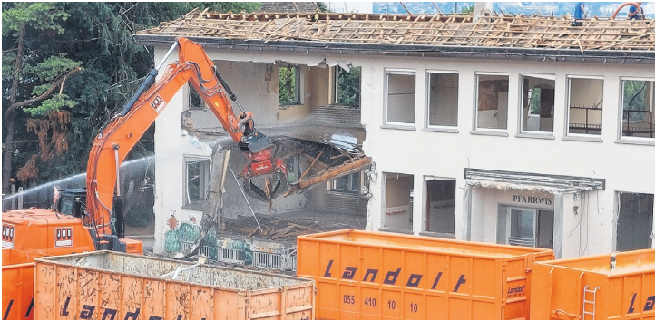
Der Abbruch nimmt seinen Lauf.
