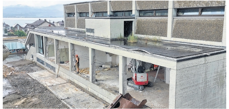
Ungeahnte Einblicke in die Gebäudehülle.
