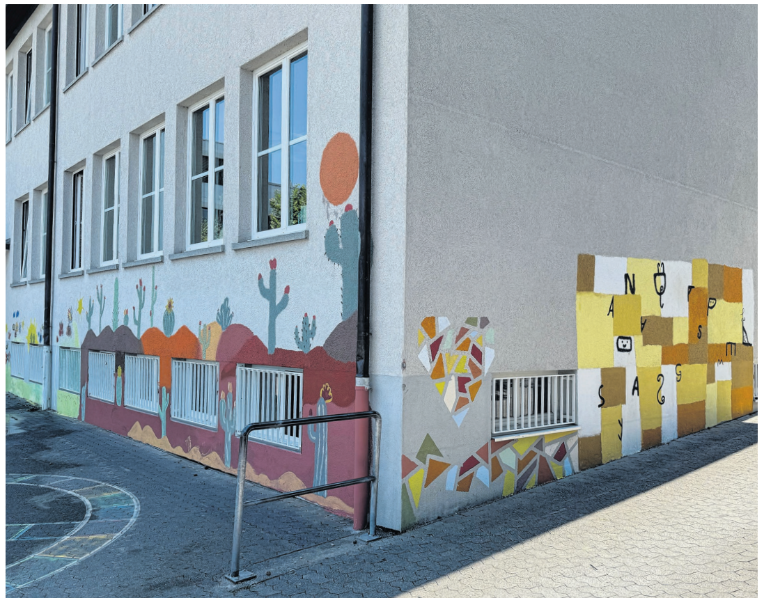
Zum Abschied nochmals eine bunte Fassade: Das Schulhaus Pfarrwis in Altendorf, das in den nächsten Tagen abgerissen wird, erhielt von Schülerhand viel Farbe.
